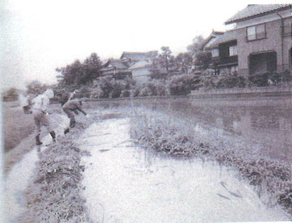
昭和61(1986)年7月13日梅雨前線豪雨の翌日の写真。(下流 福庭地内) 当時は素掘り水路であり、水位の上昇が見られている。
