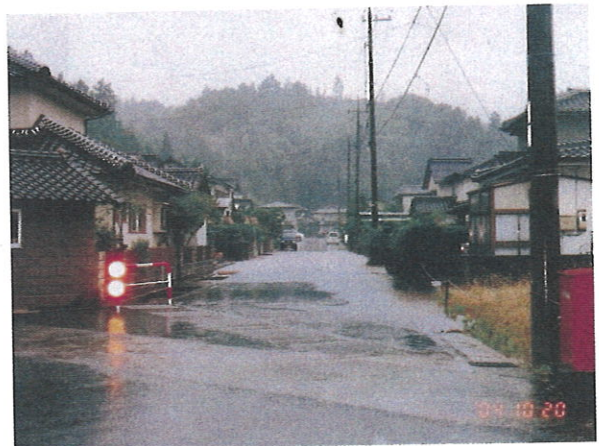
平成16(2004)年10月20日 台風23号 市道冠水状況
